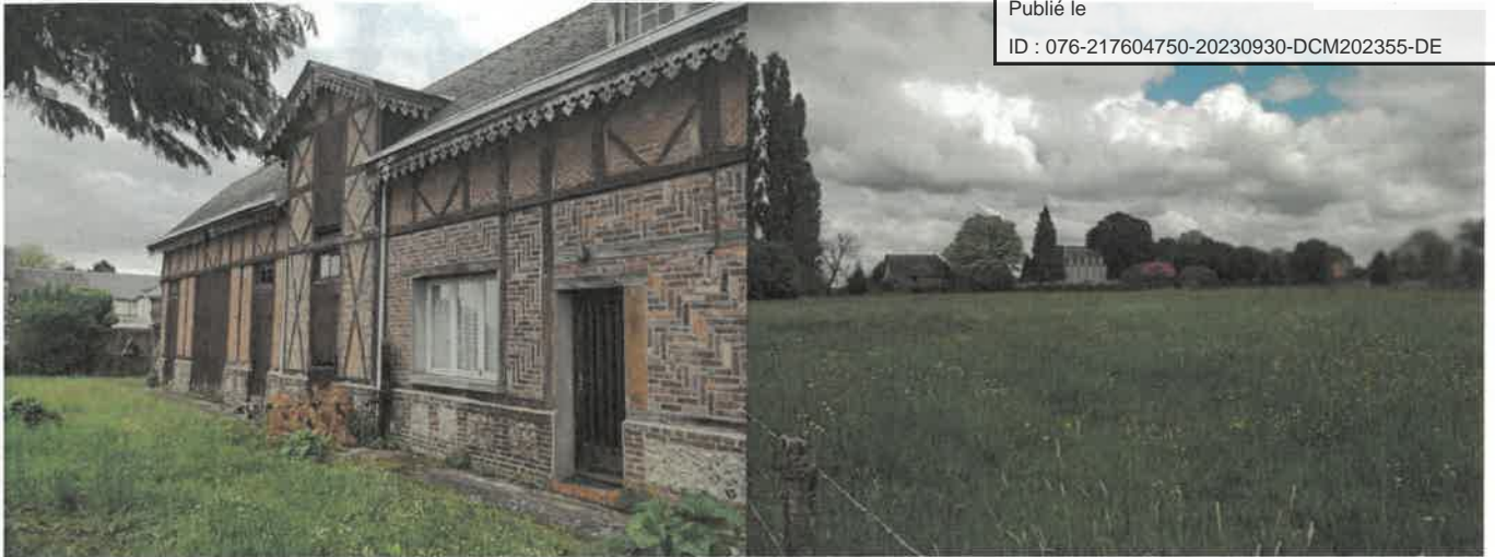
Maison infestée à démolir
