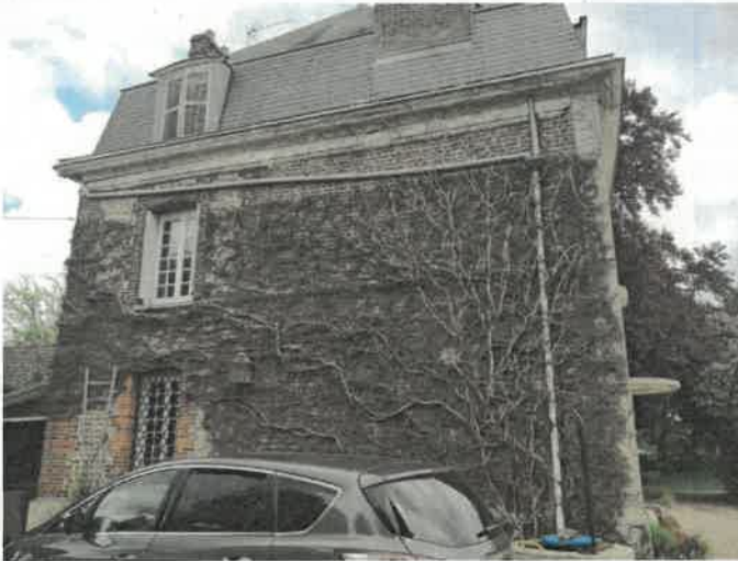
Vue extérieure – pignon ouest
